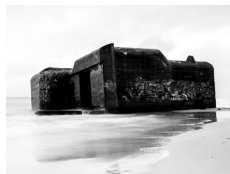
HD21 Løkken - Bunker V
